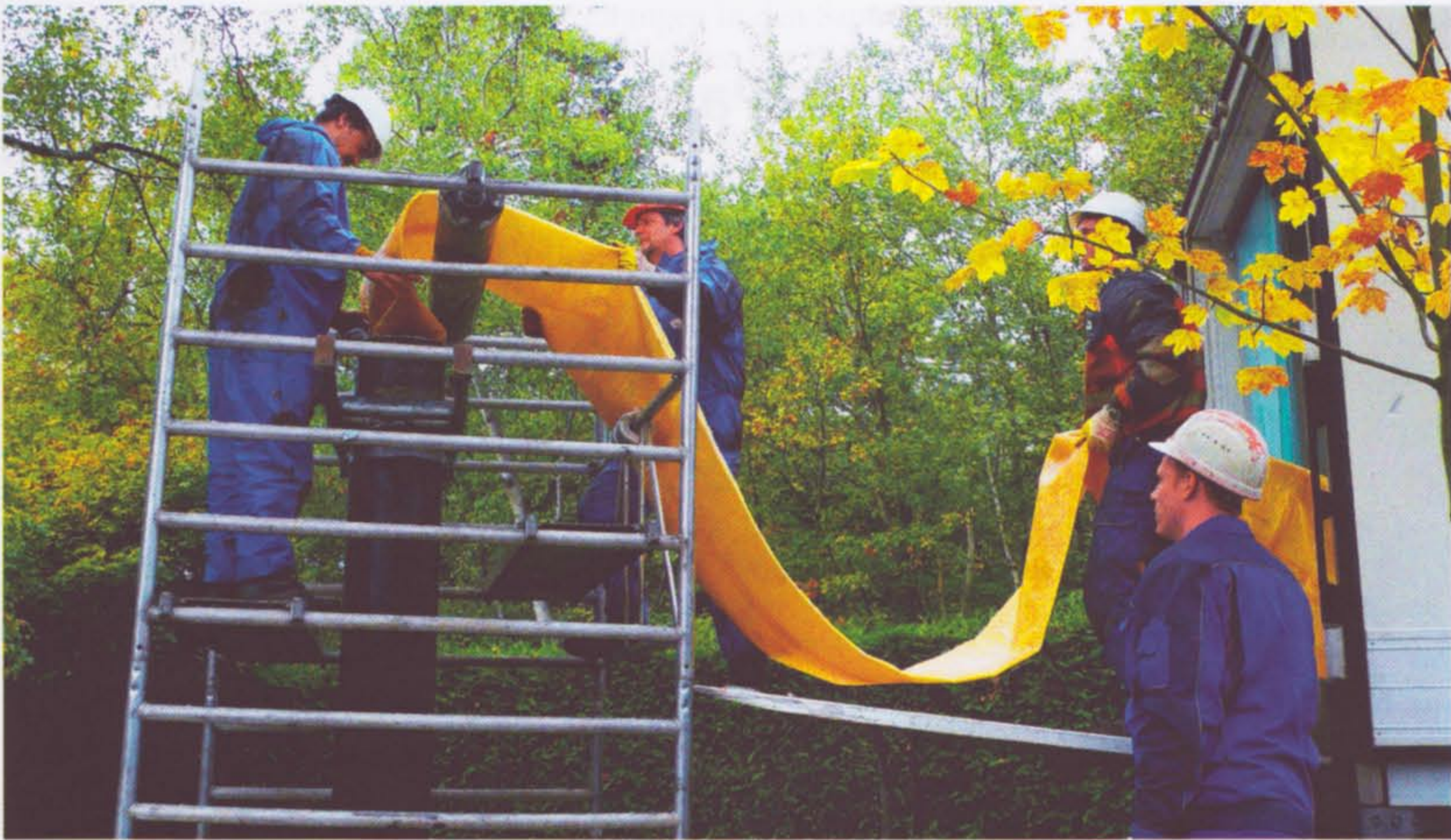
Der innere Liner wird im Reversionsverfahren per Wassersäule in den ersten Liner eingestülpt.
