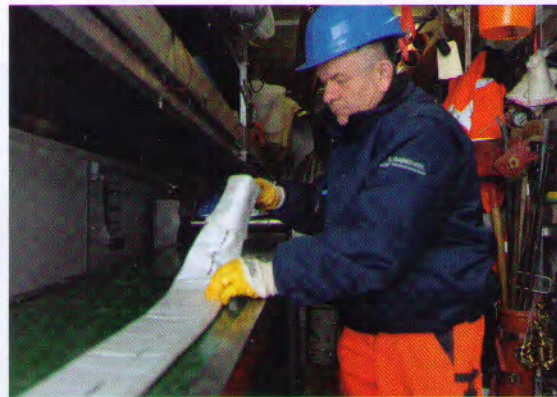
» Jeder Handgriff sitzt: Die Blomberger Spezialisten führen die Kanalsanierung ohne Freilegung der Rohre und Kanäle durch. «
