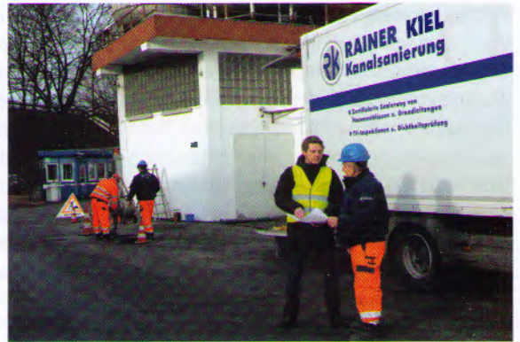
» Ohne Betriebsunterbrechung konnte die Sanierung des Kanalsystems durchgeführt werden. Fotos: Kiel Kanalsanierung «
