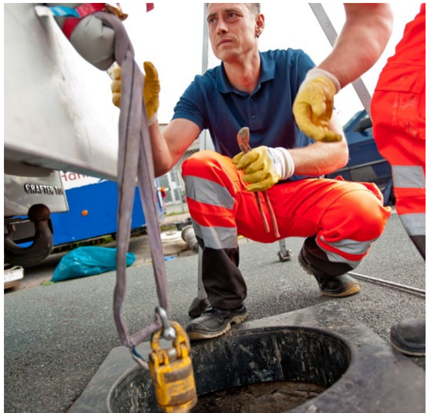
Vorbereitungsmaßnahmen für den Einzug des Inliners
